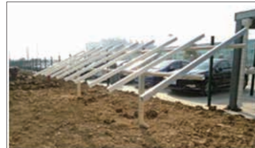
单立柱薄膜组件地面支架系统
